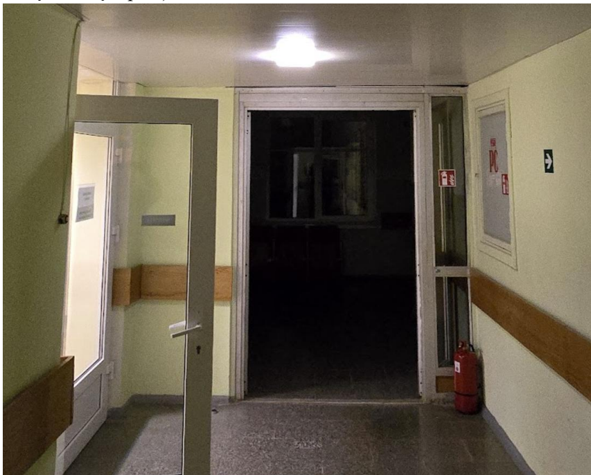
6 pav. Vidaus gaisrinio vandentiekio sistema tarybinių laikų, senovinis žymėjimas dažais gaisrinių čiaupų. Pirmos pagalbos skyrius aprūpintas pirminėmis gaisro gesinimo priemonėmis
